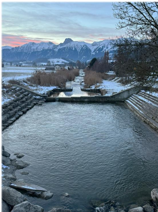
Hochwasserschutz Mühlethurnen (Januar 2026)
