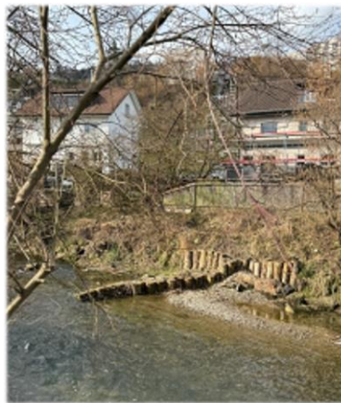
Auflandungsentfernung oberhalb Steinbachbrücke, Strömungselemente (Herbst 2025)
