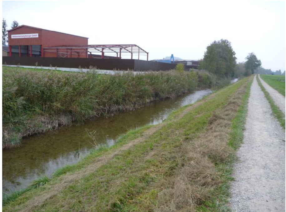
Abbildung 19: Der Betriebsstandort Balsiger Altstoffverwertung/Autoverschrottung entlang der Gürbe. Blick Richtung SE.
