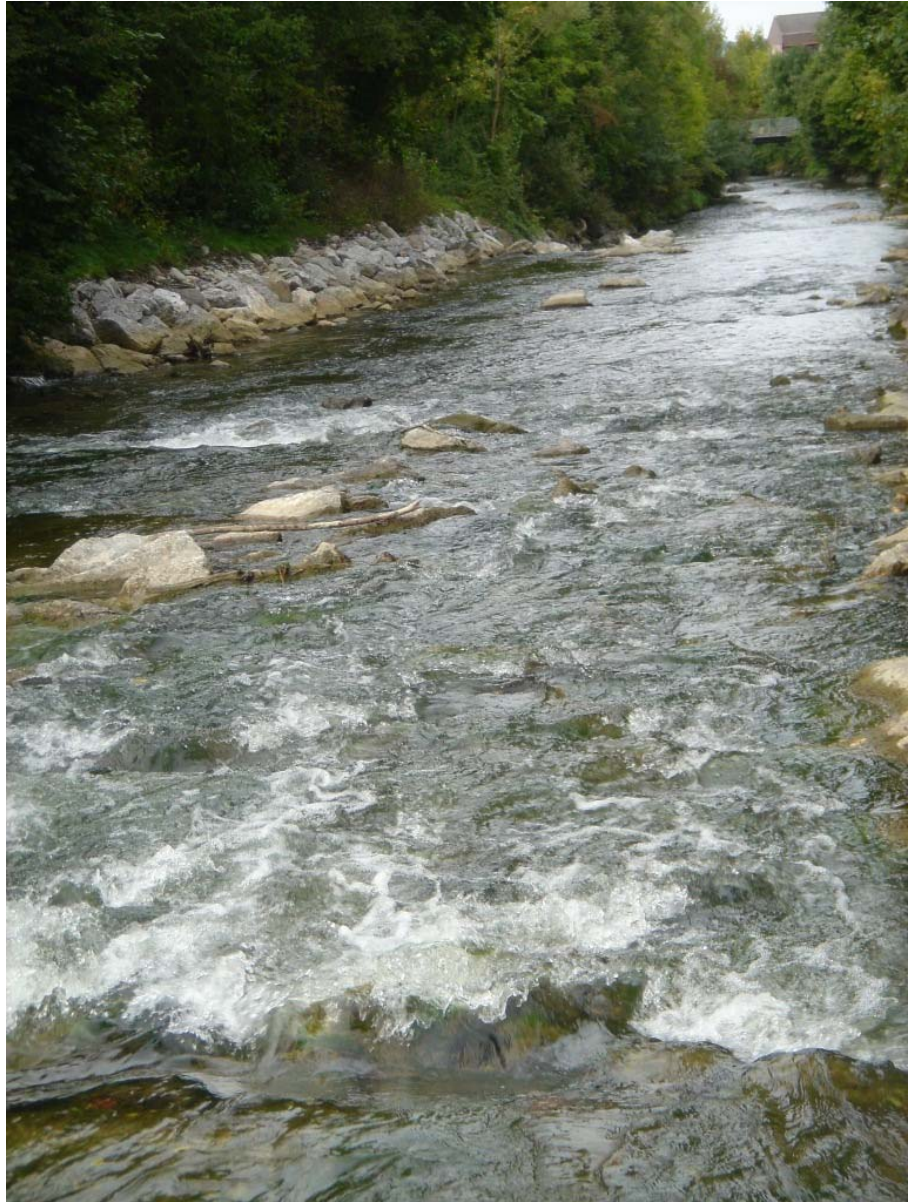
Abbildung 1: Ausgeführte Längsvernetzung Mülimatt / Belp Im Hintergrund der Husmattsteg (Sägetstrasse).
